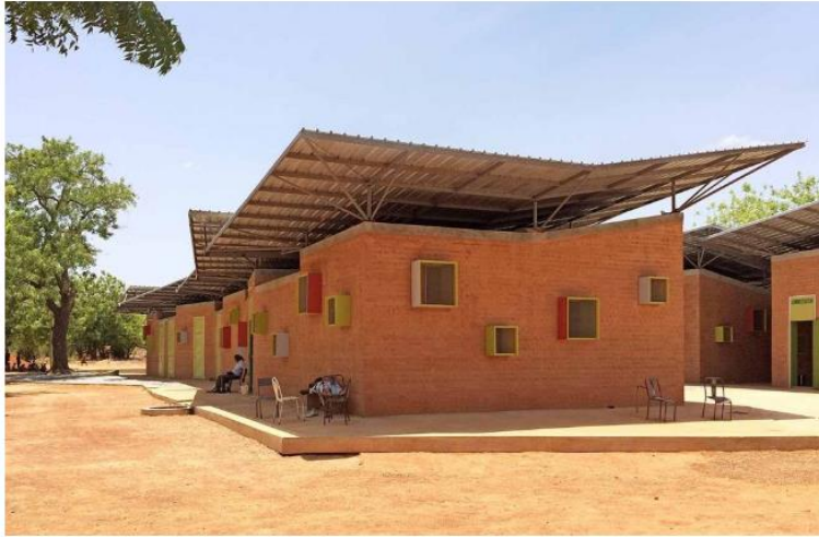
Abbildung 15 Modulare Struktur. Mauern aus komprimierten und sonnengetrockneten Lehmziegeln
