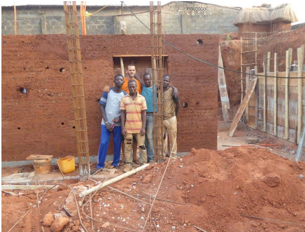
Abbildung 11 Lehmbau mit einheimischen Handwerkern. Lediglich die Fundamente sind aus Beton
